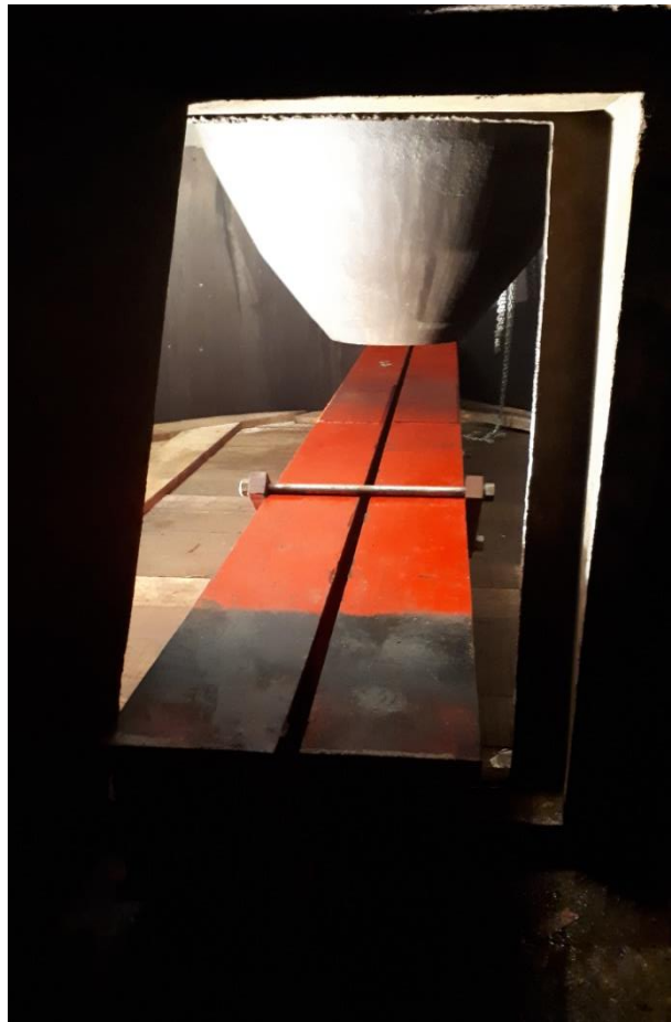
Slika 4. 5. Nosač rotora i vratila [15]
