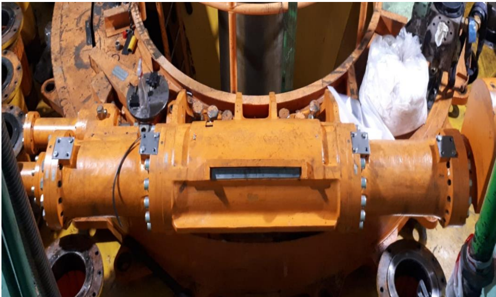
Slika 4. 25. Servo motor privodnog aparata [15]
