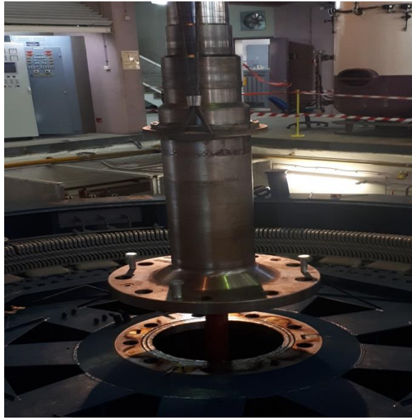
Slika 4. 9. Osovinski nastavak [15]
