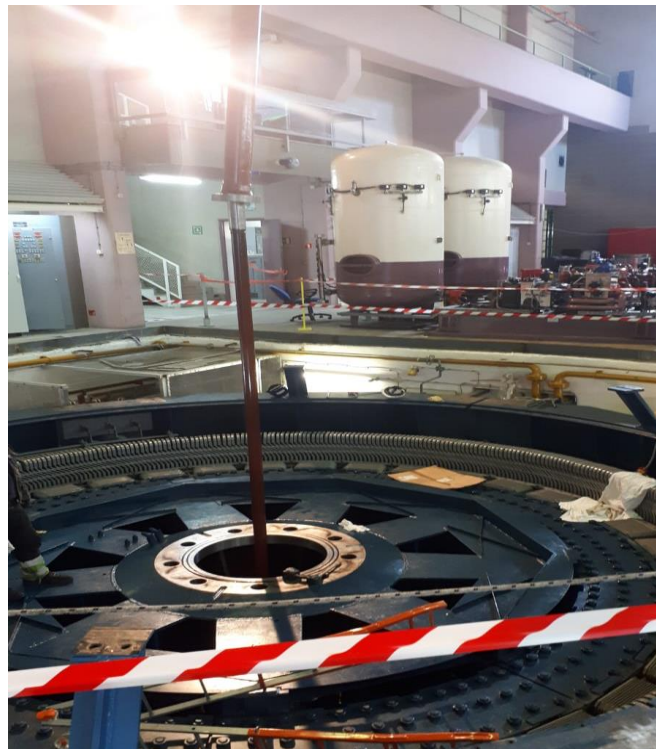
Slika 4. 10. Cijevi u vratilu [15]
