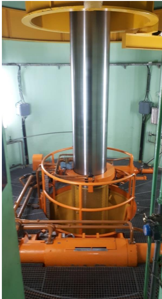
Slika 4. 22. Vratilo turbine [15]
