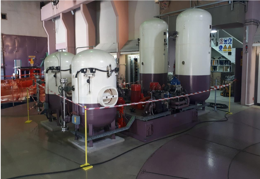
Slika 2. 4. Spremnici tlačnog ulja [15]
