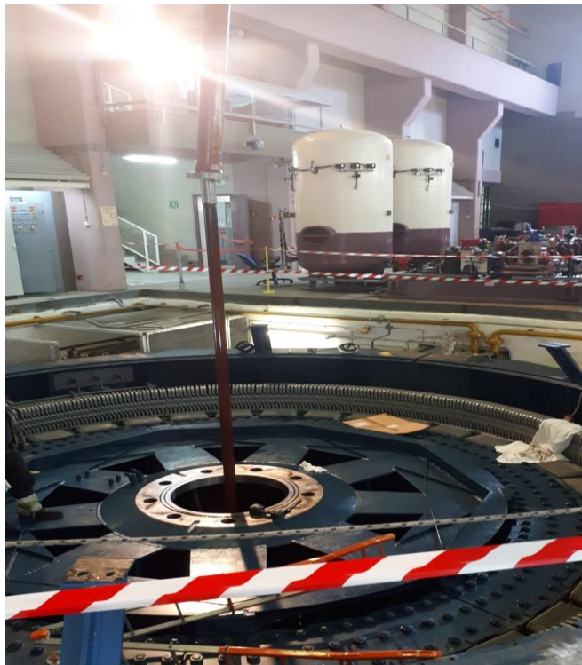
Slika 4. 10. Cijevi u vratilu [15]
