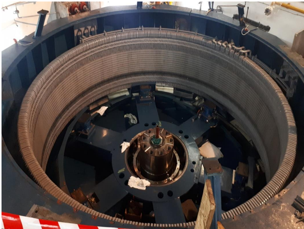
Slika 4. 16. Stator [15]
