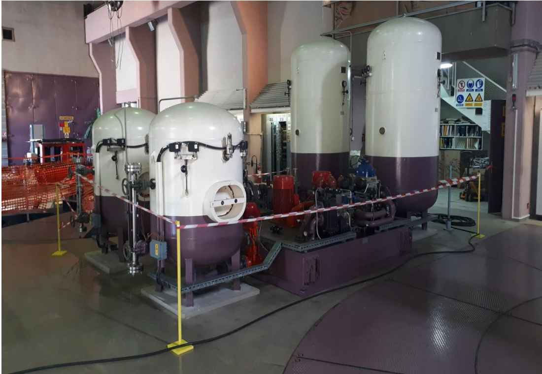
Slika 2. 4. Spremnici tlačnog ulja [15]
