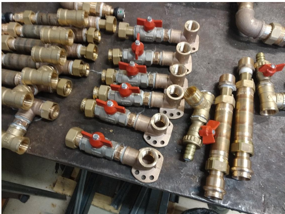
Slika 5.27 - Priprema sklopa izljevnikog mjesta
