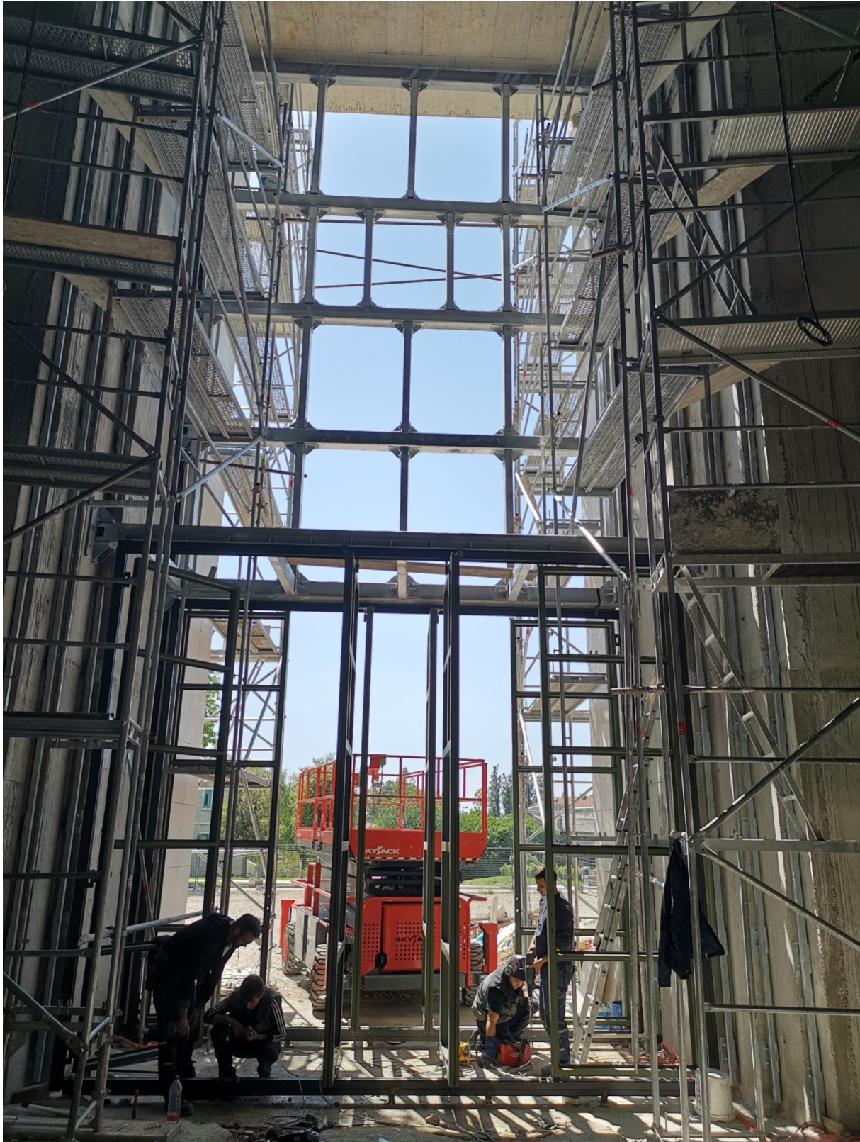
Slika 7.17 - Završena nosiva konstrukcija portala bazilike
