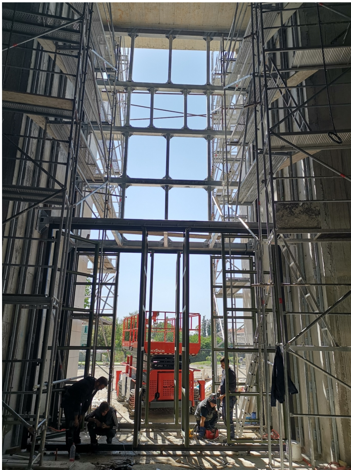
Slika 7.17 - Završena nosiva konstrukcija portala bazilike
