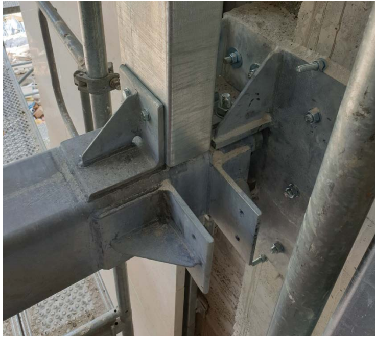
Slika 7.13 - Spoj vertikalnog i horizontalnog nosača
