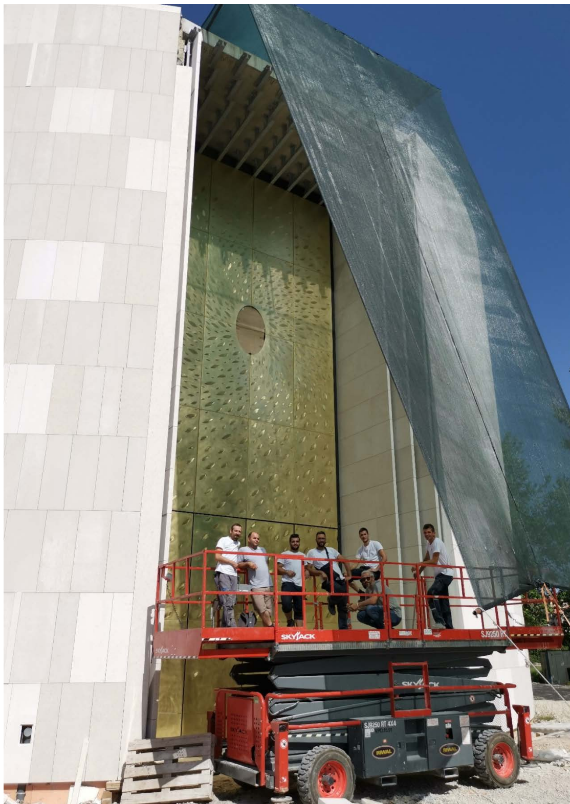
Slika 7.37 - Gotova konstrukcija obložena dekorativnom oblogom
