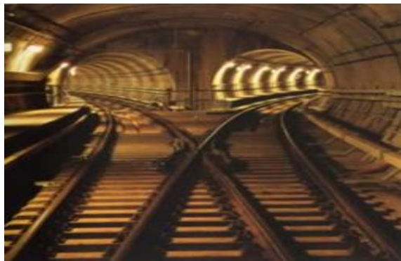
Slika 8. Korozija lutajuće struje u tunelu [9]
