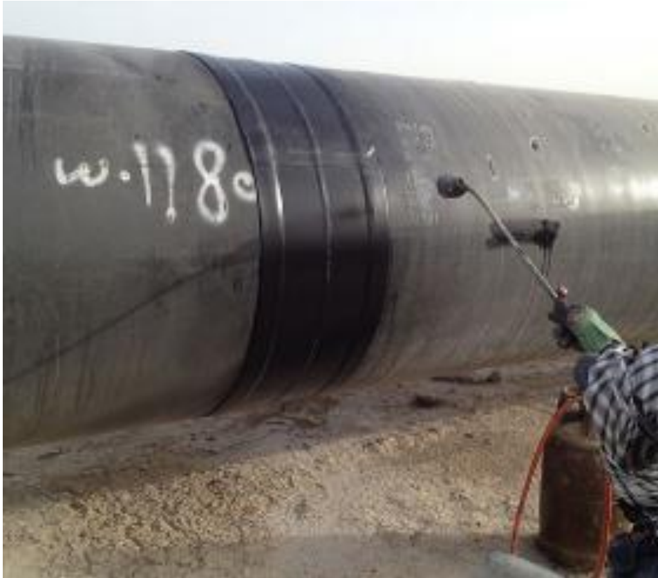
Slika 5.17 Nanošenje skupljajućih prevlaka [37]
