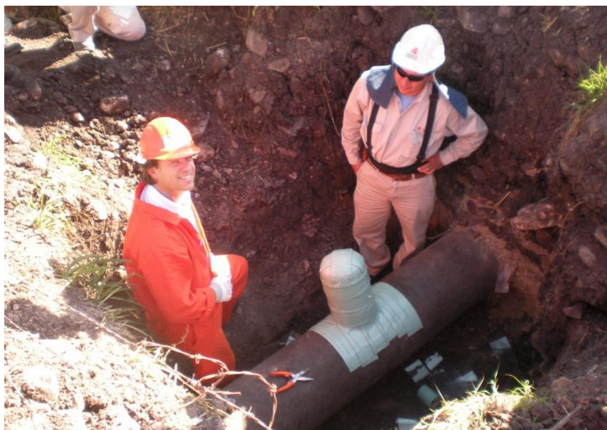
Slika 5.14 Nanošenje vanjskog sloja viskoelastičnih obloga na T-spoj cjevovoda [32]
