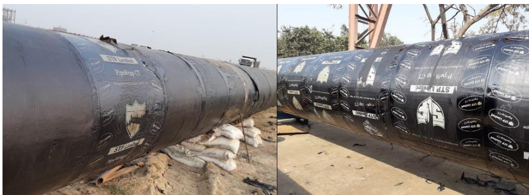
Slika 5.5 Primjer premaza na bazi katrana [26]
