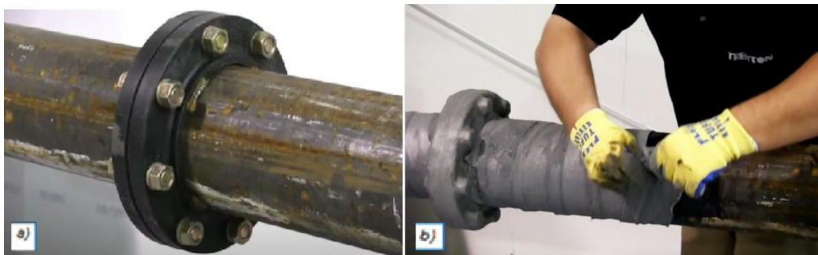
Slika 5.16 Postupak nanošenja prevlake na bazi voska; a) Prirubnica prije nanošenja presvlake; b) Prirubnica poslije nanošenja prevlake; [33]
