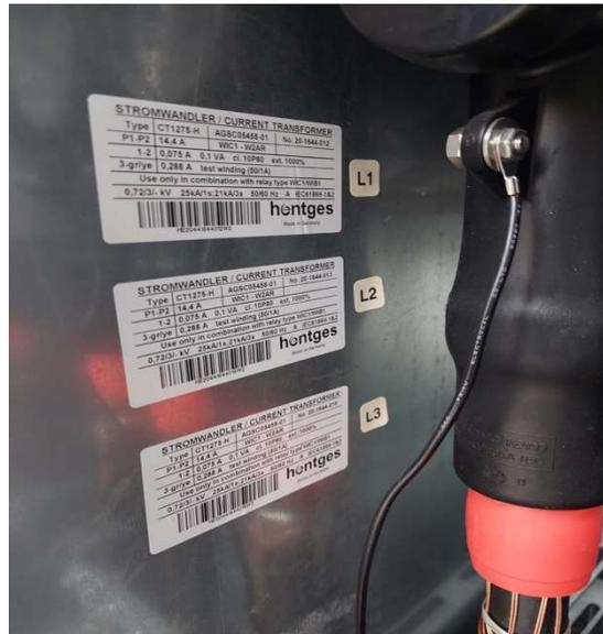
Slika 5.4. Natpisne pločice strujnih transformatora unutar SN bloka TS Duboka [37]
