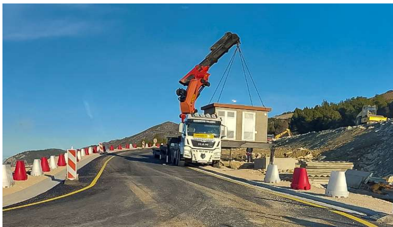
Slika 5.1. Montaža TS Duboka 10(20)/0,4 kV [37]
