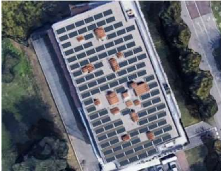
Slika 5.10. Zgrada sa solarnom elektranom [14]
