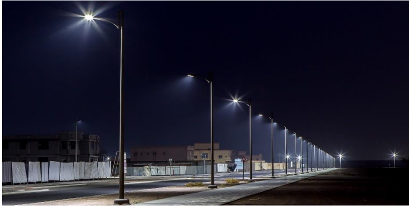
Slika 2.5. Primjer vanjske rasvjete - rasvjeta prometnice [9]
