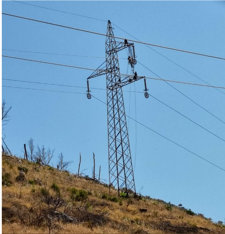
Slika 5.2. Armiranje nosivog stupa
