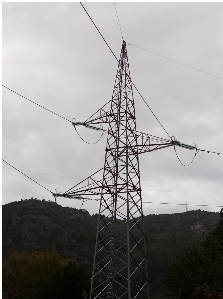
Slika 5.7. Zatezni stup nakon završene elektromontaže
