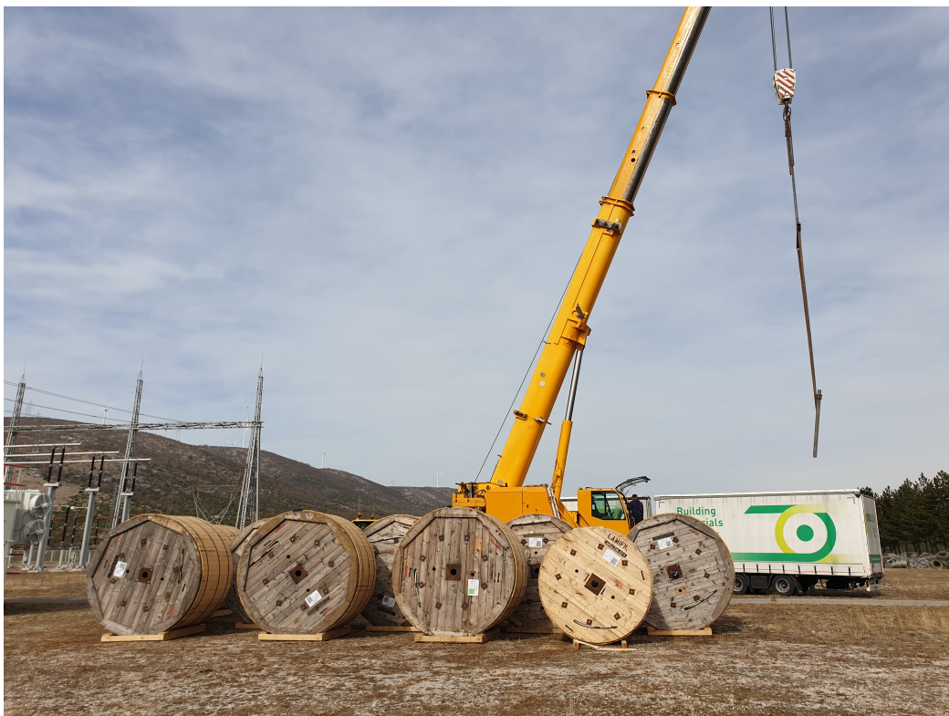
Slika 5.1. Istovar bubnjeva sa ACCC vodičem u TS Konjsko
