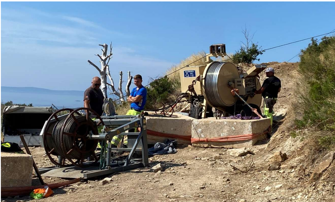
Slika 5.4. Stroj za razvlačenje vodiča, vučni stroj
