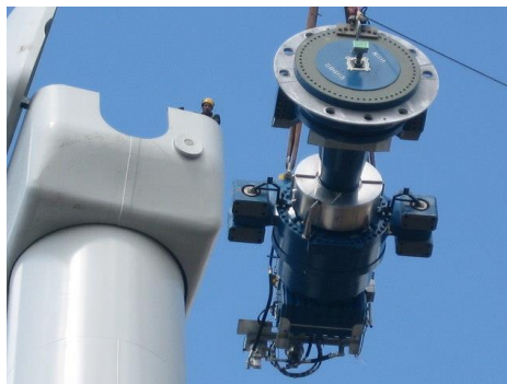
Slika 8. Rotor vjetroagregata [2]
