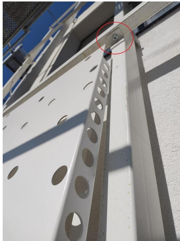
*Slika 7.4 - Spoj vertikalnog i horizontalnog nosača*
