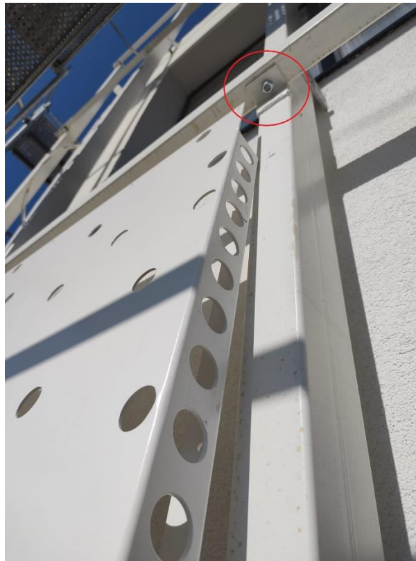
Slika 7.4 - Spoj vertikalnog i horizontalnog nosača
