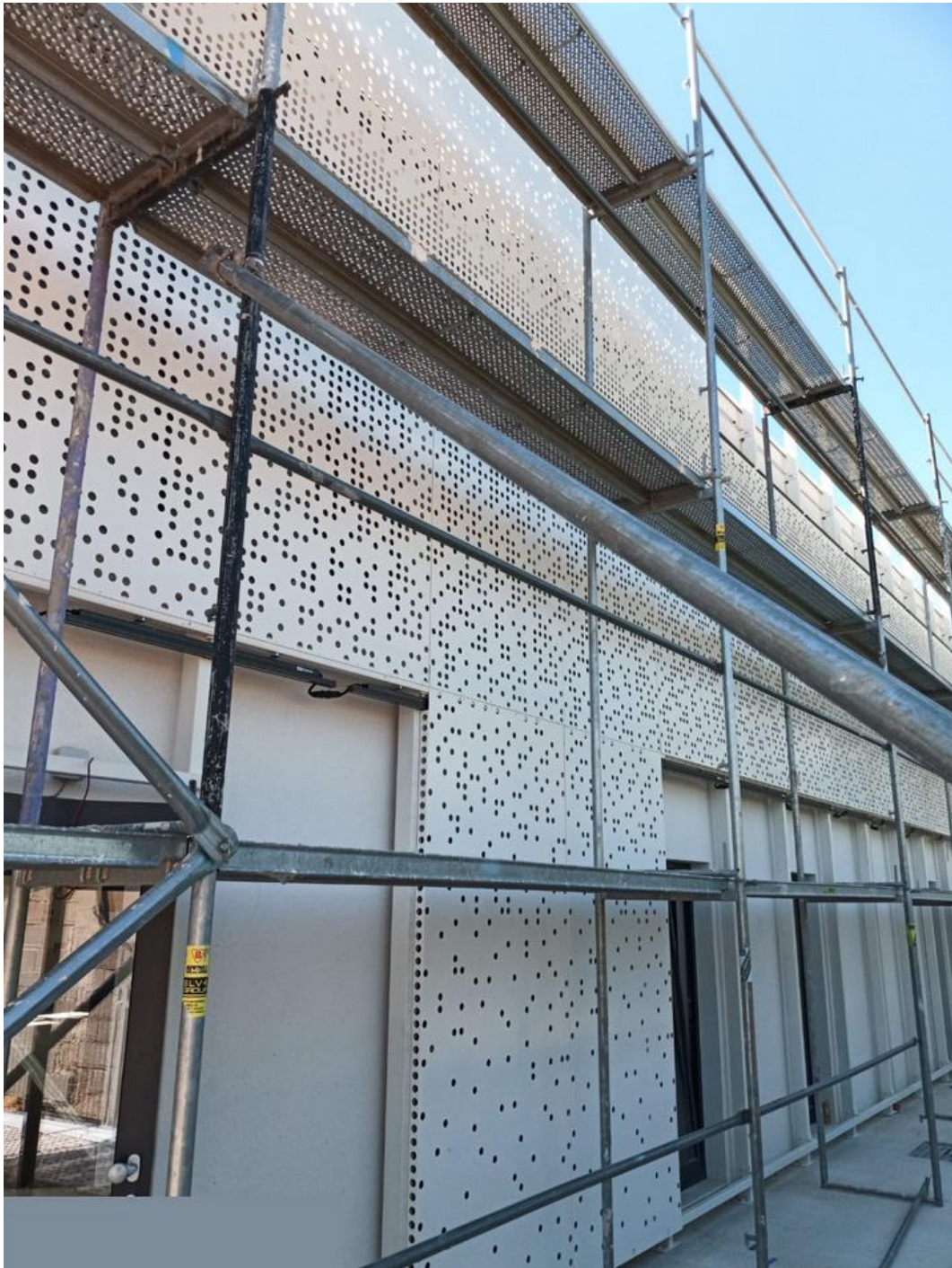
Slika 7.6 - Pogled na objekt s aluminijskom oblogom
