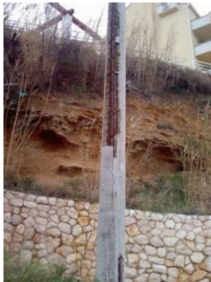
Slika 14. Betonski stup na Pagu star 10 godina
