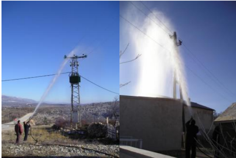
Slika 18. Pranje stupne trafostanice i stupa
